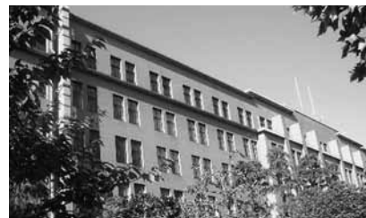
1939年竣工の現財務省の建物だが、4階部分の底には爆撃に備えて鉄板が入っている
